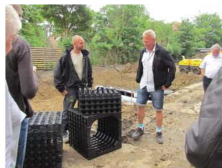
Figur 17: Faskinekassetter ved anlægsarbejde i Valby. Foto Orbicon
