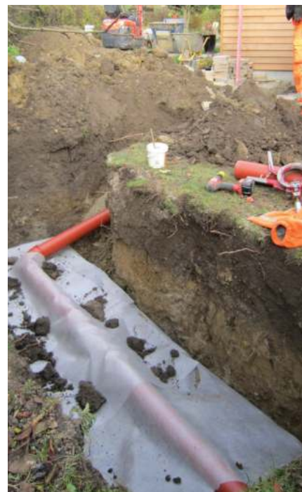
Figur 15: Faskine under udførelse. Faskinen er blevet pakket ind i geotekstil, som forhindrer den omkringliggende jord i at trænge ind i faskinen. Regnvandet ledes til faskinen via det orange rør. Lindevang i Brøndby. Foto Spildevandscenter Avedøre.
