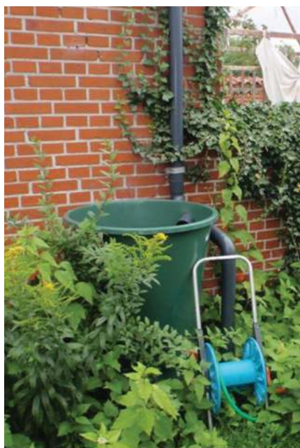
Figur 31: Regnvandstønde ved nedløbsrør i parcelhushave. Slagslunde, Egedal Kommune. Foto Orbicon.
