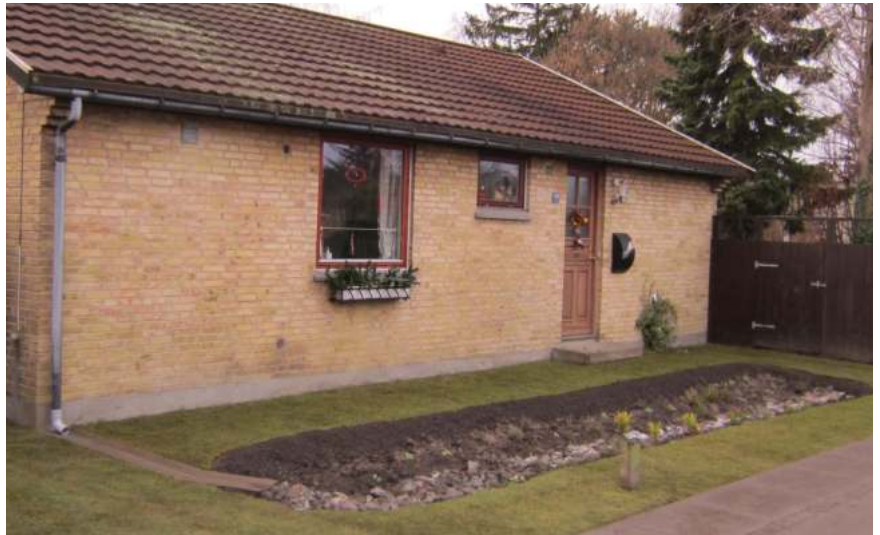
Figur 18: Nyetableret regnbed. Regnvandet ledes til regnbedet via en åben fliserende. Ved skybrud vil vandet løbe ud på vejen (bort fra huset). Brøndby Kommune har efter en vurdering af det konkrete projekt, lempet for de vejledende afstandskrav til bebyggelse og skel. Foto Spildevandscenter Avedøre.
