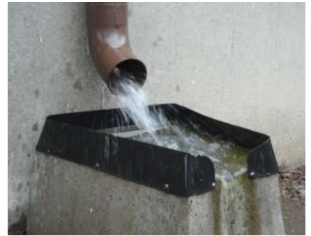
Figur 1: (Forsidebillede): Afkoblet nedløbsrør i bebyggelsen Augustenborg i Malmø. Foto Orbicon.
