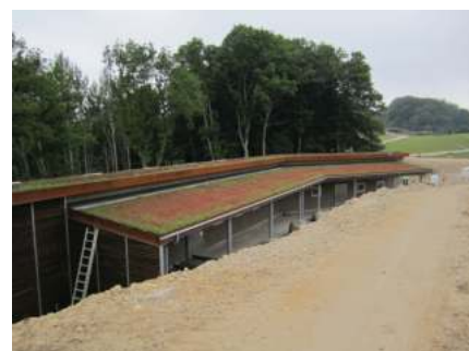
Figur 29: Sedumtag, Ree dyrepark. Foto Orbicon
